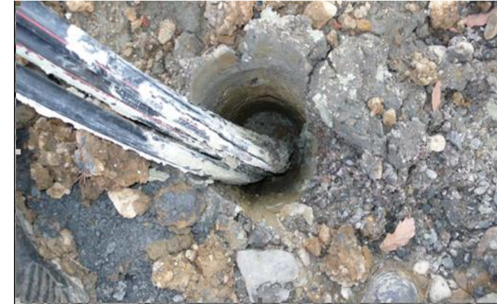
Mise en place de la sonde et cimentation
