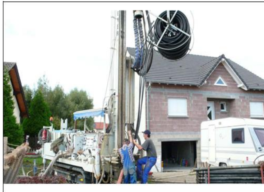
Mise en place de la sonde
