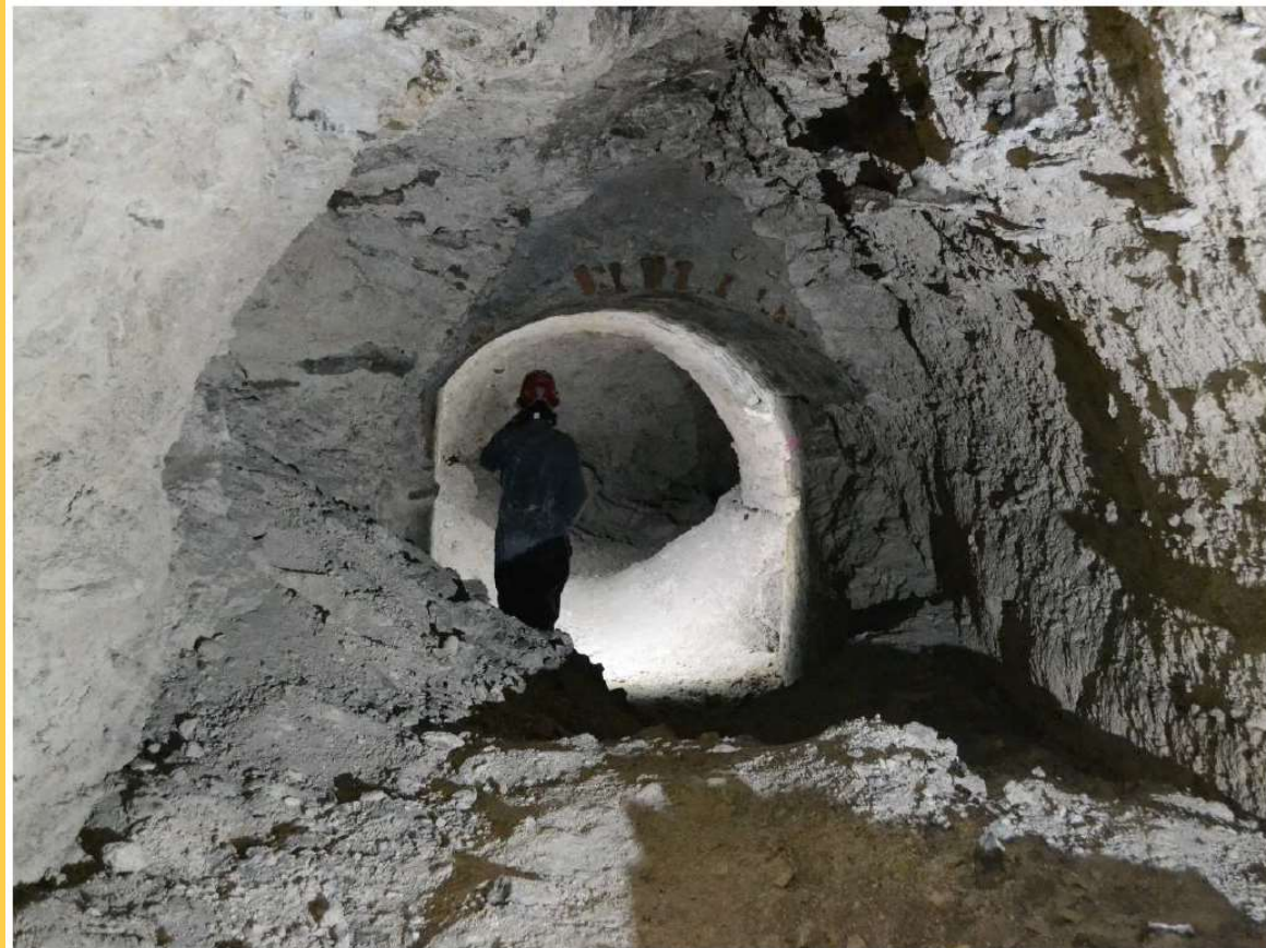
Carrière Faubourg Saint-Vincent (Cerema, 2020)
