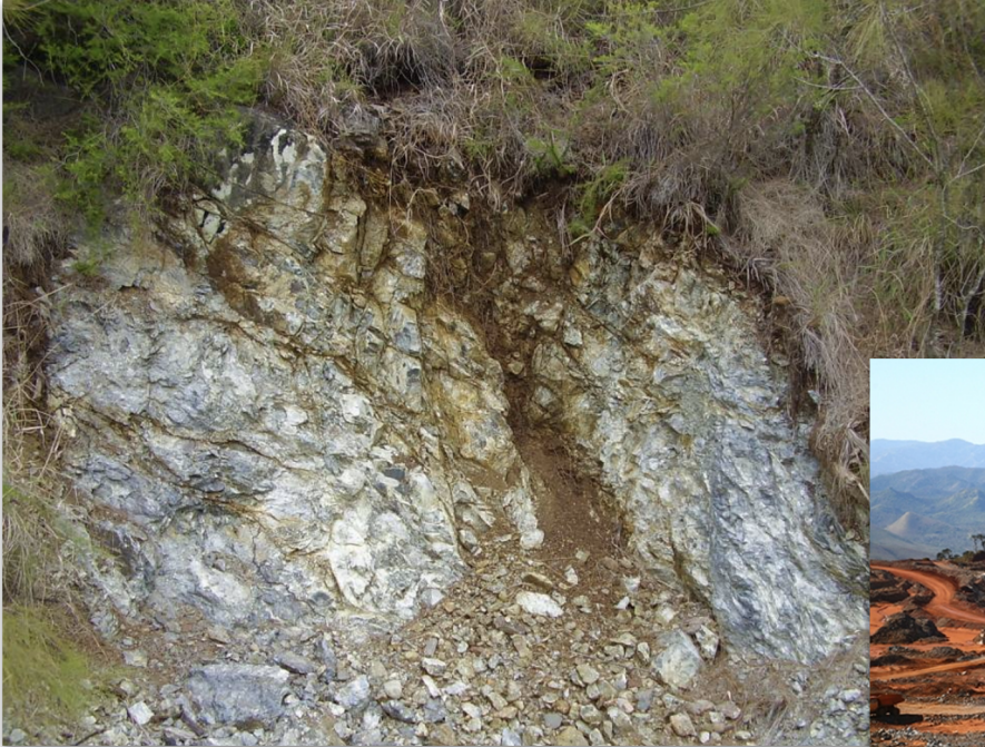
Talus de terrassement dans des formations de serpentinite, tribu de Nedivin, commune de Houaïlou
