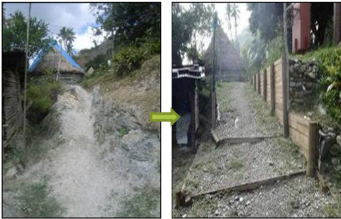
Chantier de la Tribu de Tendo
