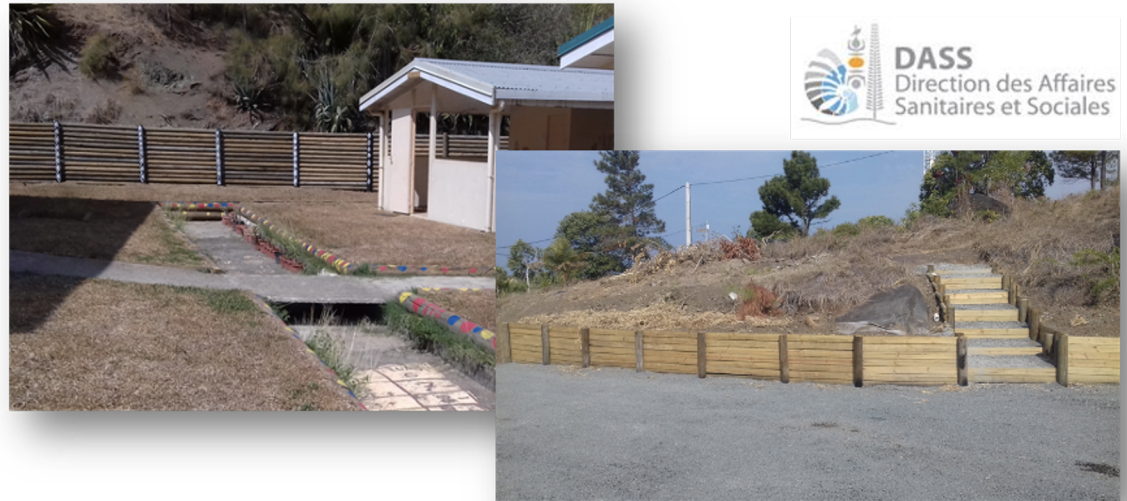
Chantier de Kaala-Gomen
